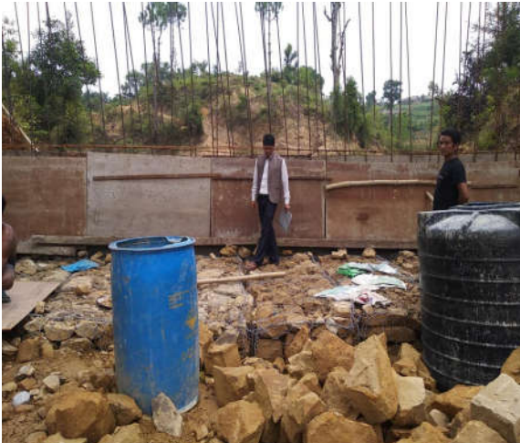
वंगलाचुली गा.पा.वडा नं. ८ निर्माणाधिन चेक ड्याम
