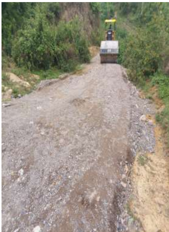
ग्राभेल सडक निर्माण कार्य सम्पन्न
