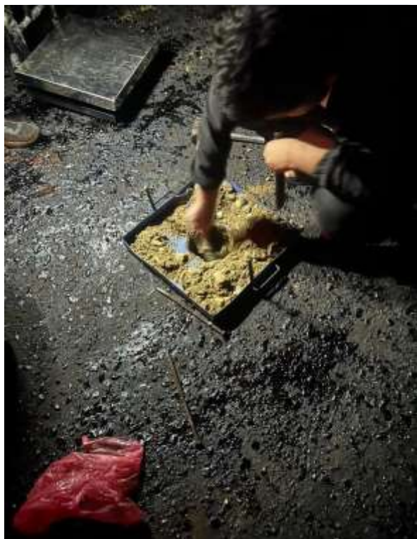
सडक निर्माण गुणस्तर परीक्षण
