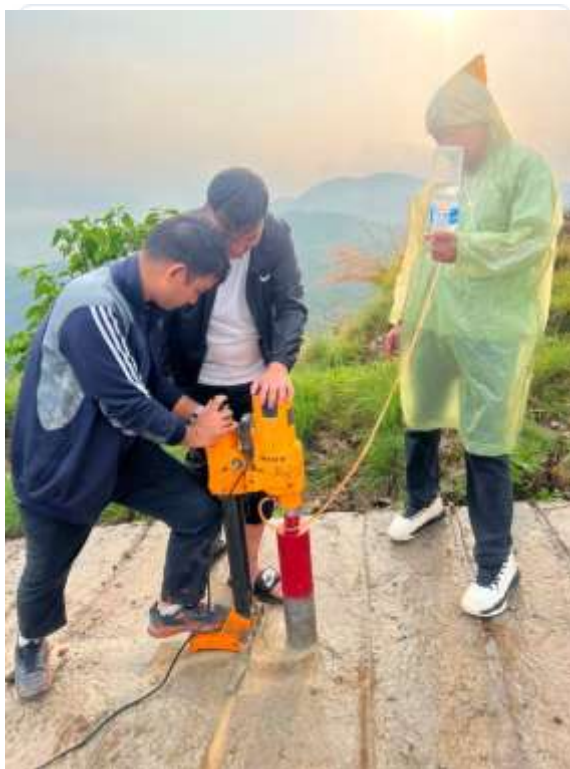
RCC मा Core cutting गर्दै
